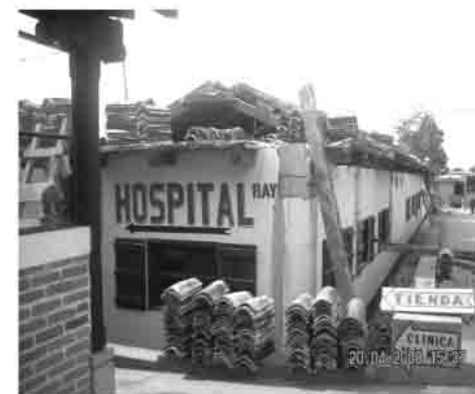
Construcción del Techo Hospital
